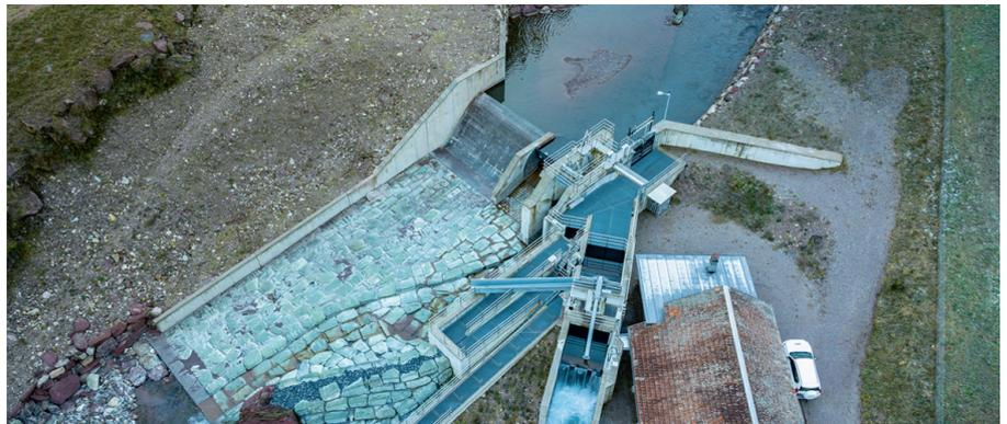
Le nouveau système de captage de la centrale de Schils peut être franchi par les poissons et les sédiments.
